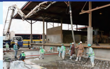
1 DAY PAVE 試験施工
