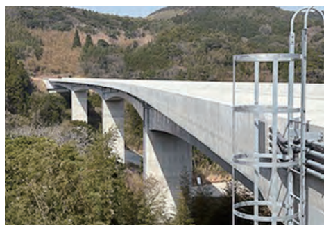
三隅・益田道路 PC 高架橋
