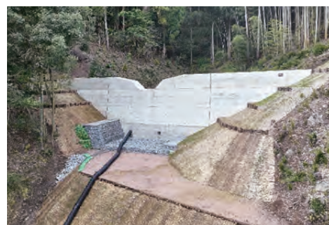
治山事業（谷止工）
