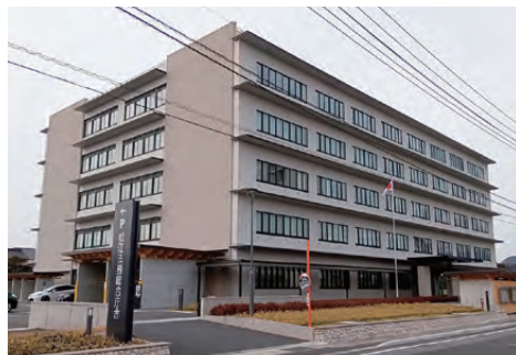
松江法務総合庁舎
