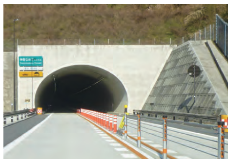
出雲湖陵道路 神西なめさトンネル
