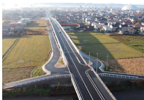
今市矢尾線 里方跨線橋
