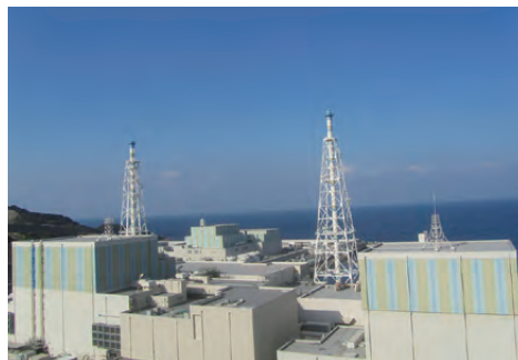
島根原子力発電所
